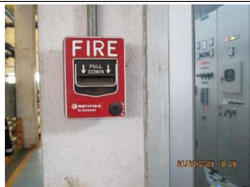
รูปที่ 2-63 ระบบตรวจจับสัญญาณเตือน (Fire Alarm)
