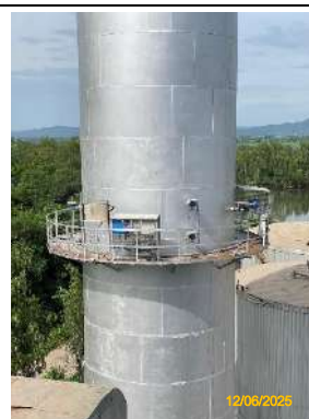
รูปที่ 2-20 เครื่องมือหรืออุปกรณ์พิเศษ รายงานมลพิษจากปล่องหม้อไอน้ำ (CEMs)
